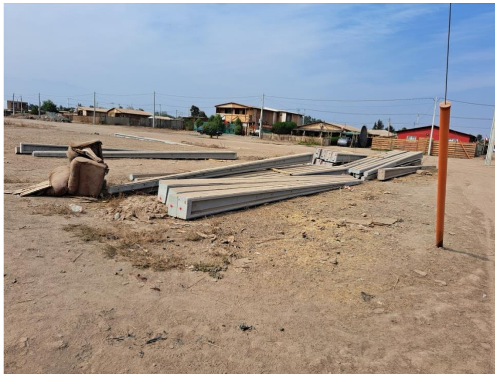
Postes de concreto de ENEL esperando ser instalados en 2022
