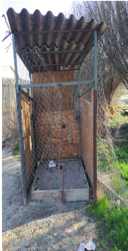
La caseta que guardaba el tablero de la electricidad tomada
